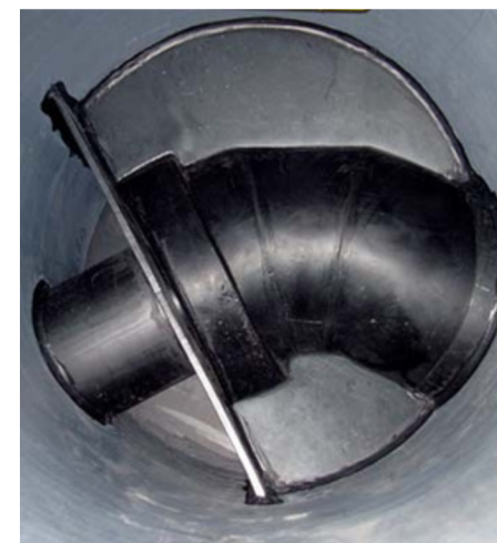
Studnia kinetowa z kaskadą – wewnątrz
