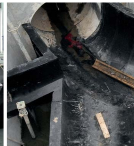
Kinety wielkowymiarowe – instalacja
